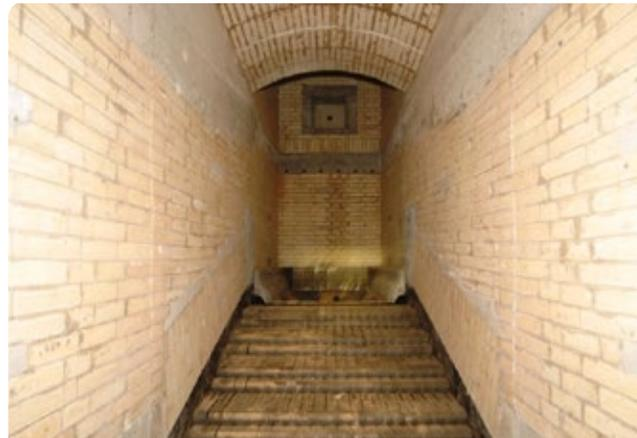
Kombinierter Retorten-/Stufenrost 5.000 kW
