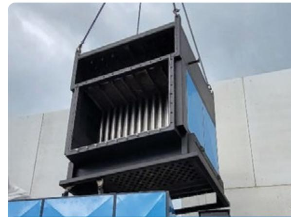
Générateurs d'air chaud 4.000 kW / 130°C
