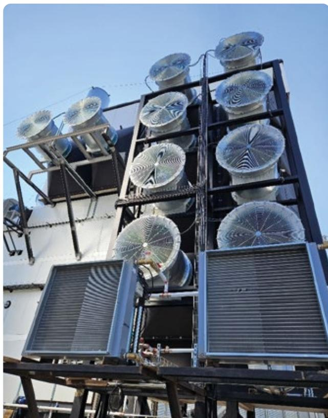
Générateurs d'air chaud 14.500 kW / 90°C
